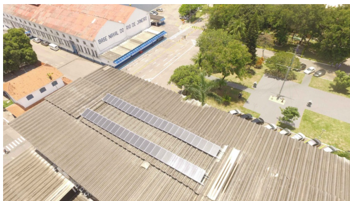
Figura 5 – Primeiro Sistema Solar Fotovoltaico da BNRJ Integrado à Rede Elétrica
